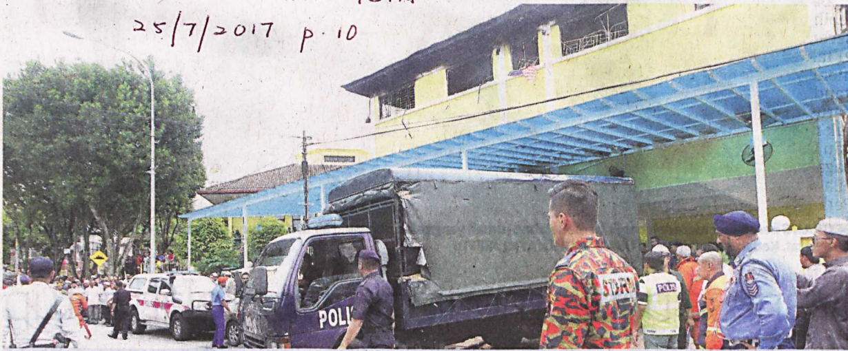
TRAGEDI kebakaran Maahad Tahfiz Darul Quran Ittifaqiyah. Keramat baru-baru ini hingga mengorbankan 23 nyawa seharusnya memberi banyak iktibar kepada semua pihak terutama berkaitan dengan usaha penambahbaikan terhadap keselamatan bangunan untuk para pelajar. - UTUSAN/JEFFRI IRAN
