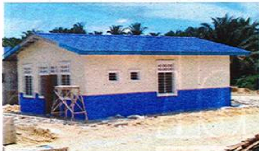
ANTARA rumah yang dibina syarikat triple A di Kampung Durian, Kuala Krai, Kelantan dengan menggunakan Putra Blok.
