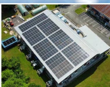
Loji Pemandu, FSTM (107.80 kWp)
