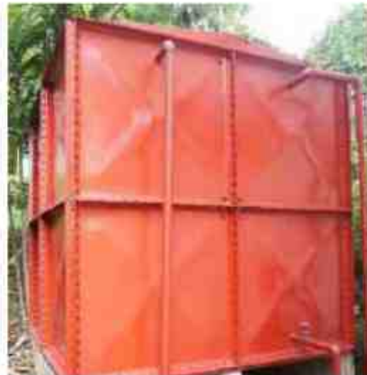
Selenggara dan mengecat semula tangki 'Hose Reel'
