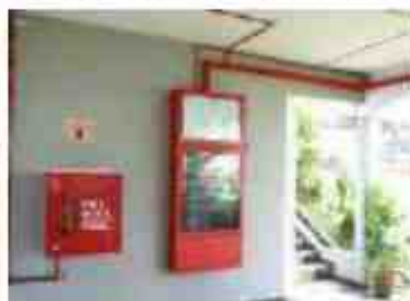
Pemasangan 'Fire Alarm Panel'
