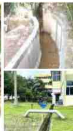
Kerja-kerja naik taraf sistem air bersih dari jenis asbestos cement kepada mild steel cement lining
