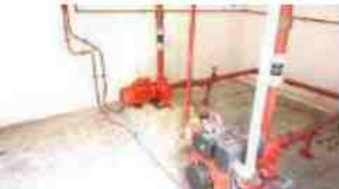
Mengganti dan baik pulih sistem pam 'Hose Reel'
