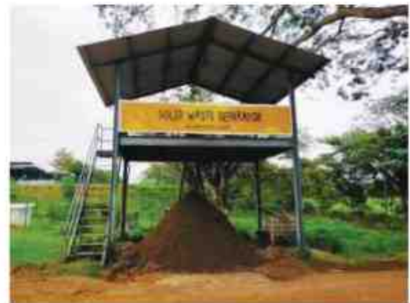
Tapak pengumpulan solid waste, kemudian dikeringkan dan dijadikan baja untuk sayuran atau ditabur di padang rumput.
