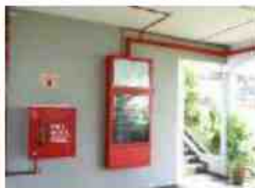
Pemasangan 'Fire Alarm Panel'
