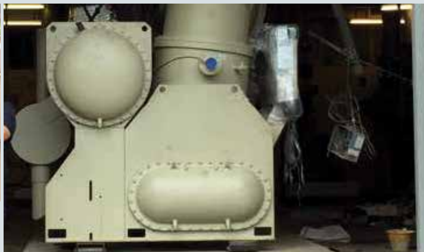
Chiller baharu jenis Trane sampai di lokasi
