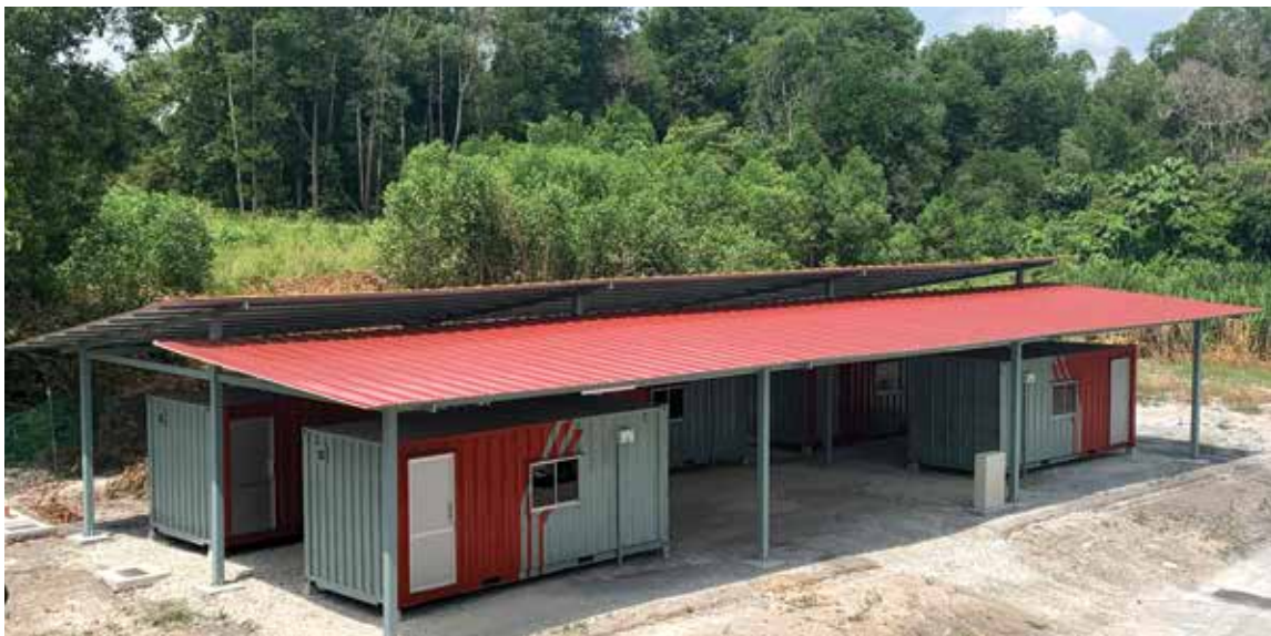
Membekal, menghantar dan memasang kontena serta membina struktur berbumbung untuk Research Room (Animal Research Facility -Non Infections Disease) di Fakulti Perubatan Veterinar, UPM Kampus Serdang.
