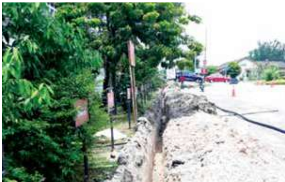
Membekal, merentang dan menguji kabel bawah tanah voltan rendah untuk Jabatan Biologi, Fakulti Sains, UPM Kampus Serdang.
