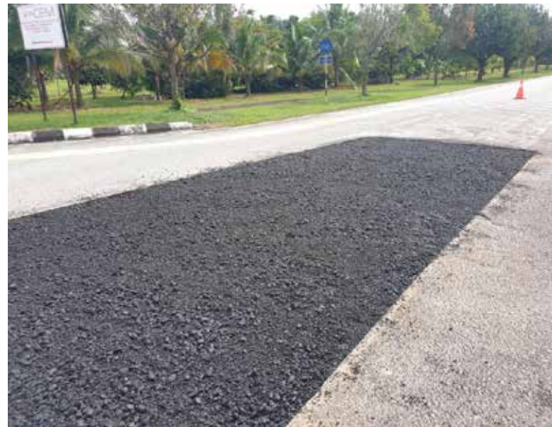
Kerja penurapan jalan
