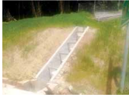
Pembaikan longkang dan cerun di Infoport
