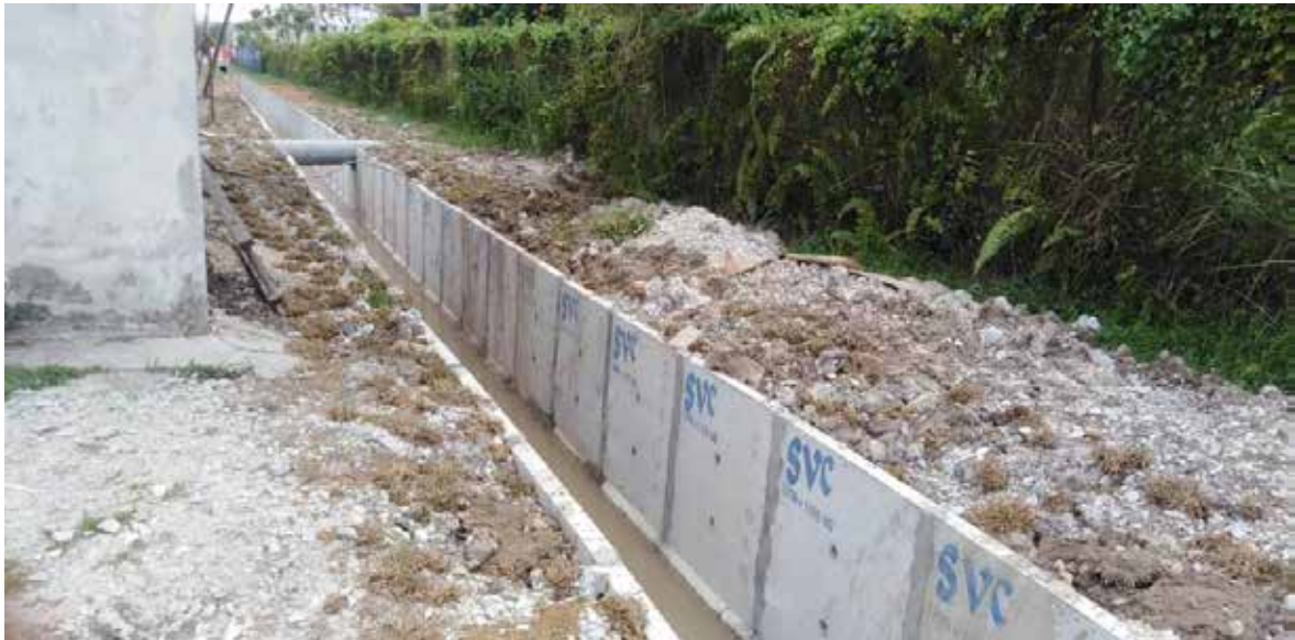
Pembinaan longkang baharu Jalan Kekabu
