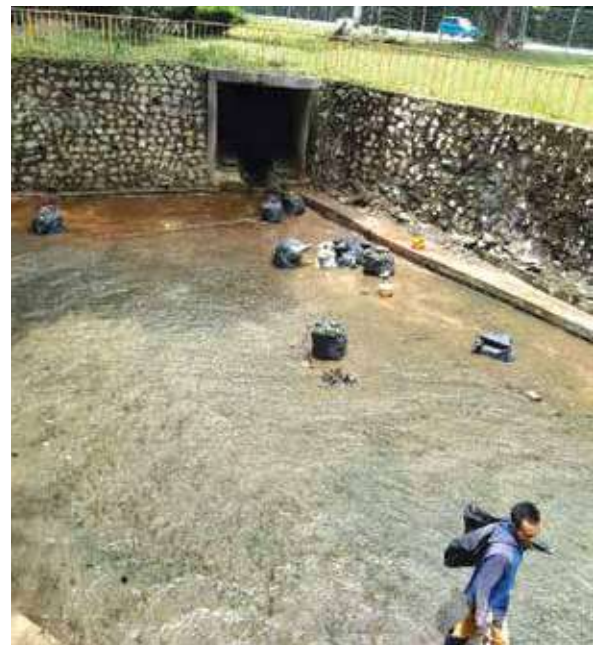
Pembersihan longkang Pintu 2
