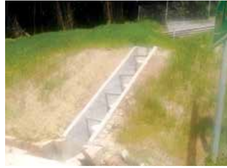
Pembaikan longkang dan cerun di Infoport
