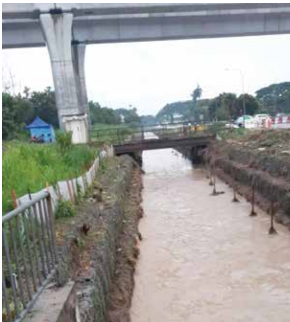
Pembersihan longkang Jalan Sapucaya
