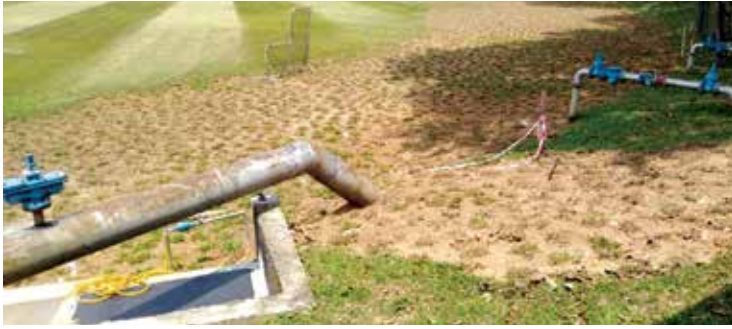
Penggantian longkang baharu di Padang Softball
