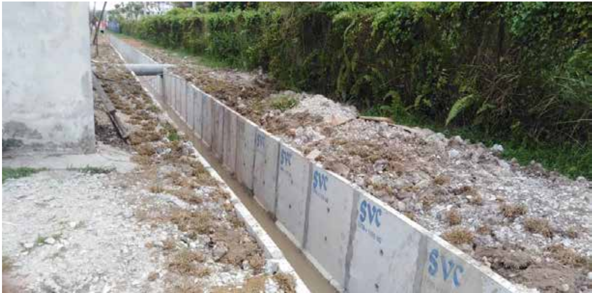
Pembinaan longkang baharu Jalan Kekabu
