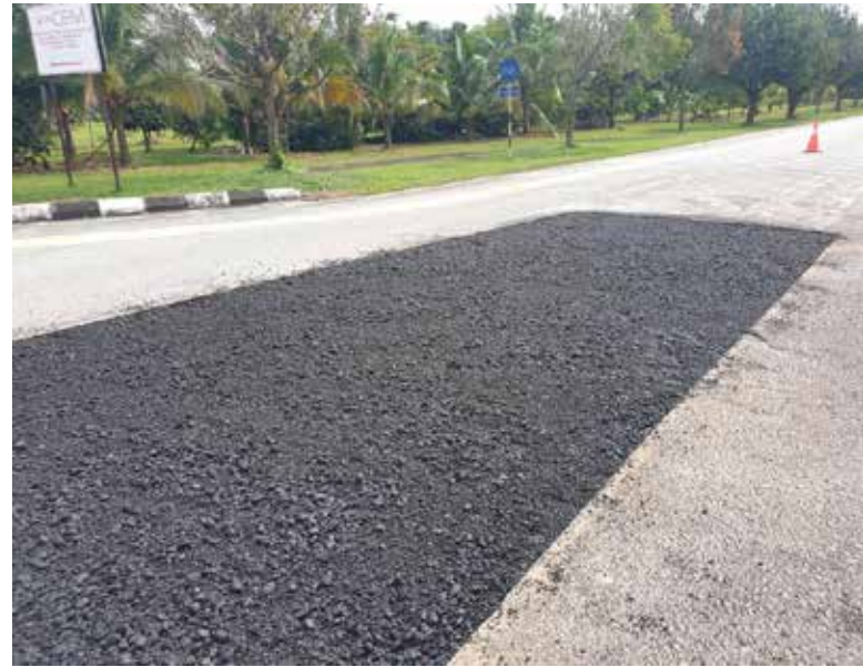
Kerja penurapan jalan
