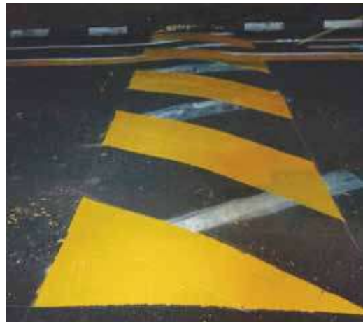
Kerja mengecat bonggol
