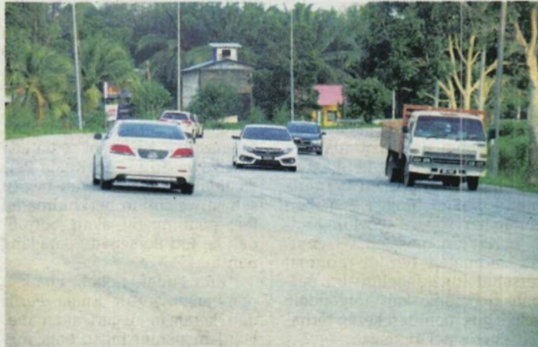
KEADAAN jalan raya di Kuantan, Pahang yang garisan putihnya hampir tidak kelihatan dan menjadi antara penyumbang kemalangan. - UTUSAN/SHAIKH AHMAD RAZIF
